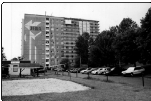
Deutlich sichtbar: Die Verjüngungskur für den „Jena-Block“ hat begonnen
